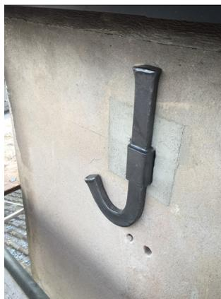
(Fotos: Rückverankerungen Turmverspannungen)
